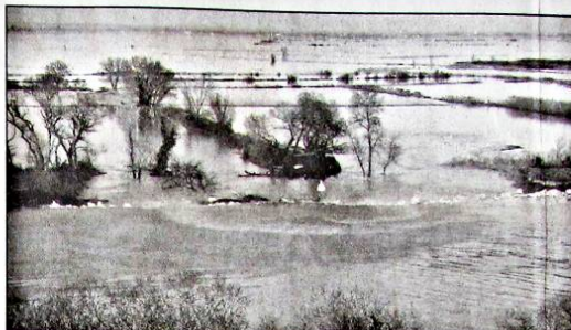
Avec des sacs de tout-venant ainsi que des poutrelles SNCF, les hélicoptères avaient pratiquement barré la voie au Rhône à Lauricet. (Photo Michel Pissano)
