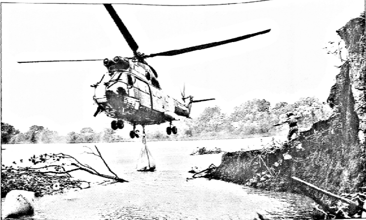
Très tôt hier, deux Pumas de l'Armée transportant des charges de 1,7 tonne afin de colmater la brèche.
