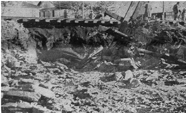
Fréjus : Le ballast de la voie ferrée s'est effondré sur 200 mètres. Seuls restent rails et traverses.
