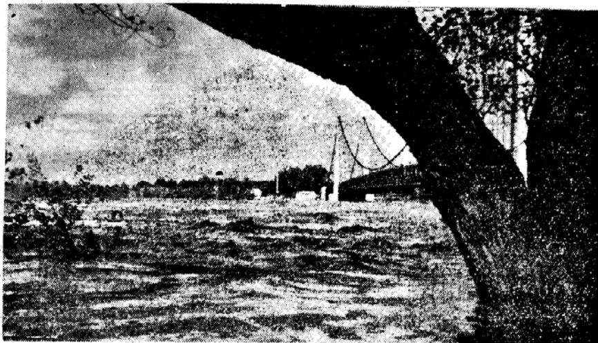
Une vue de la Durancé à proximité de Châteaurenard. L'eau a franchi la première digue. A droite le nouveau pont de Rognonas.
